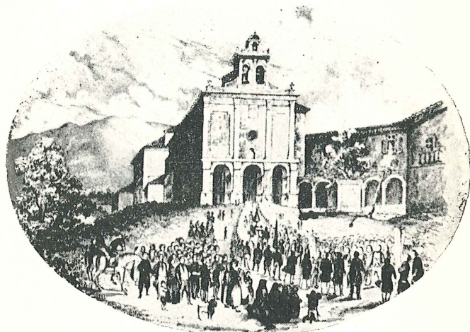
Orduña.—Santuario de Nuestra Señora de la Antigua. Es el monumento más acabado y perfecto que encierra la ciudad. Se eleva sobre una escarpada meseta que sirve de primer escalón de la Peña de Orduña. Concluyose su construcción en 1782 y se trasladó a ella el 13 de mayo del mismo año la augusta imagen de la Virgen desde la antigua ermita, cuyas ruinas aún se conservan y merecen visitarse.
